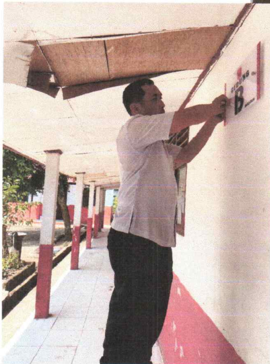
Pemasangan Label Gedung
