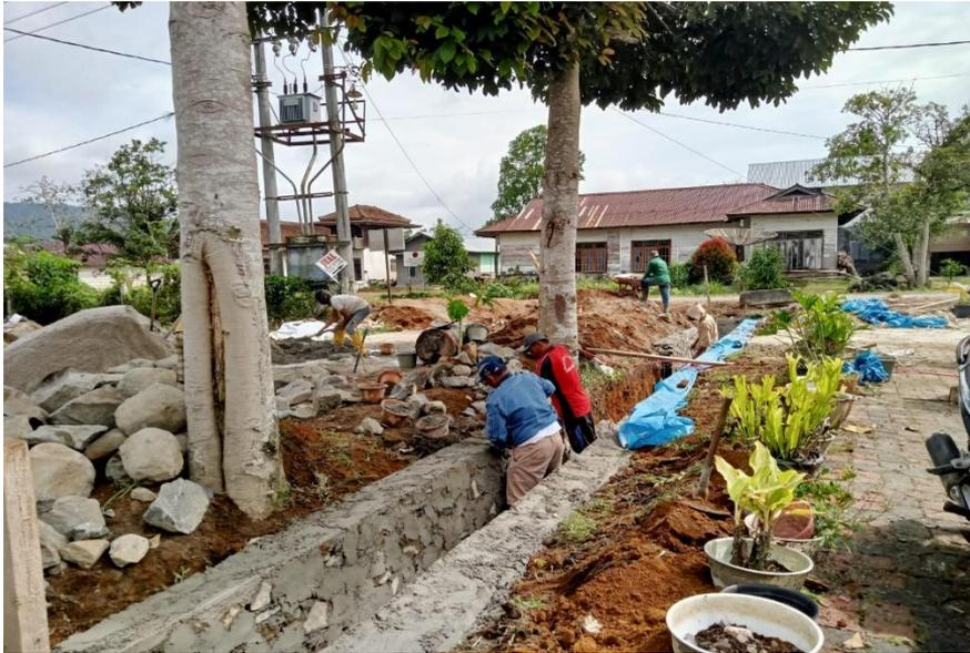
*Gambar 4. 15 Pengerjaan Drainase Asrama Polisi*
