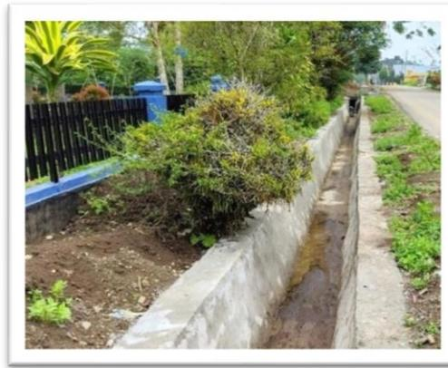
**Gambar 11.** Drainase SMP 1 Liwa sebagai Sampel Penanganan Limplanan Air
